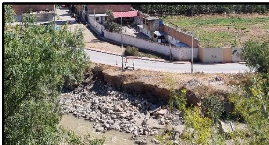
FIGURA N°02: Tramo del Río Huallaga con severa erosión en la margen izquierda, afectando una vía y exponiendo material rocoso. Se observan viviendas cercanas en riesgo debido a la inestabilidad del talud.
